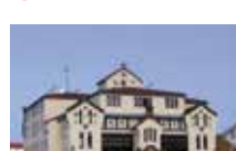
Asilo Hospital de Comillas, con el escudo de Comillas en la fachada.
